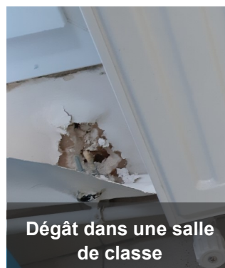
Infiltration d'eau sur la façade de l'école
